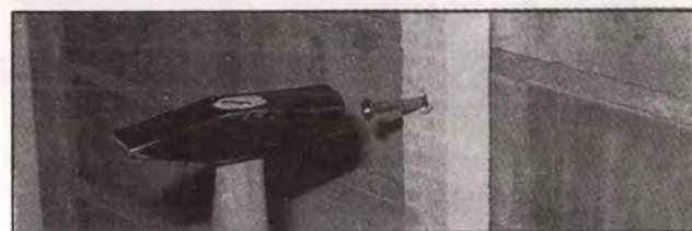
Faléc rögzítése beütődűbellel téglafalban
